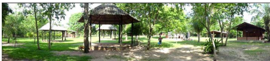
Figura 5 - Infraestrutura do balneário El Playón
