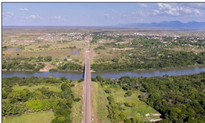
Figura 3 - Ponte sobre o Rio Tacutu
