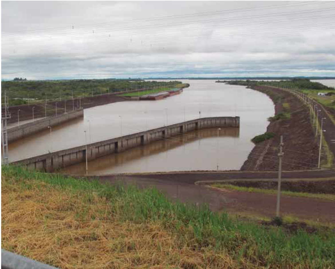
La esclusa de la presa binacional Yacyretá permite la navegación del tramo del río Paraná compartido por Argentina y Paraguay.
