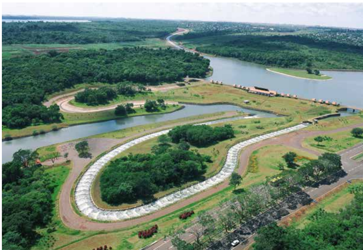
Canal de Piracema en la presa Itaipú.
