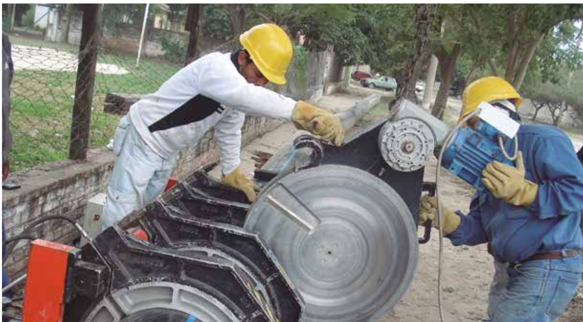
Instalación de redes troncales de agua potable.
