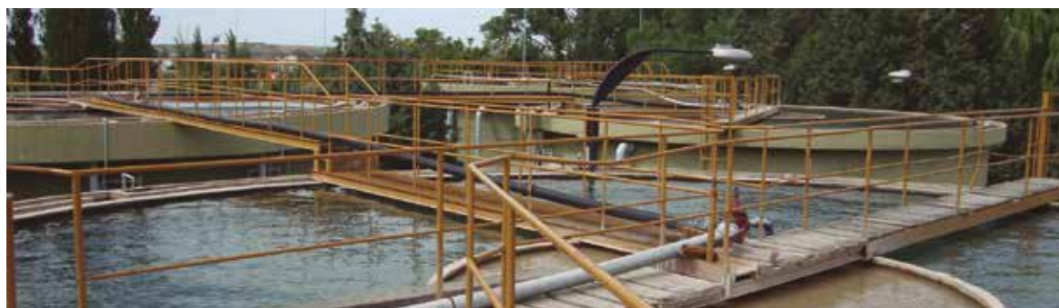
Planta de tratamiento de agua.
