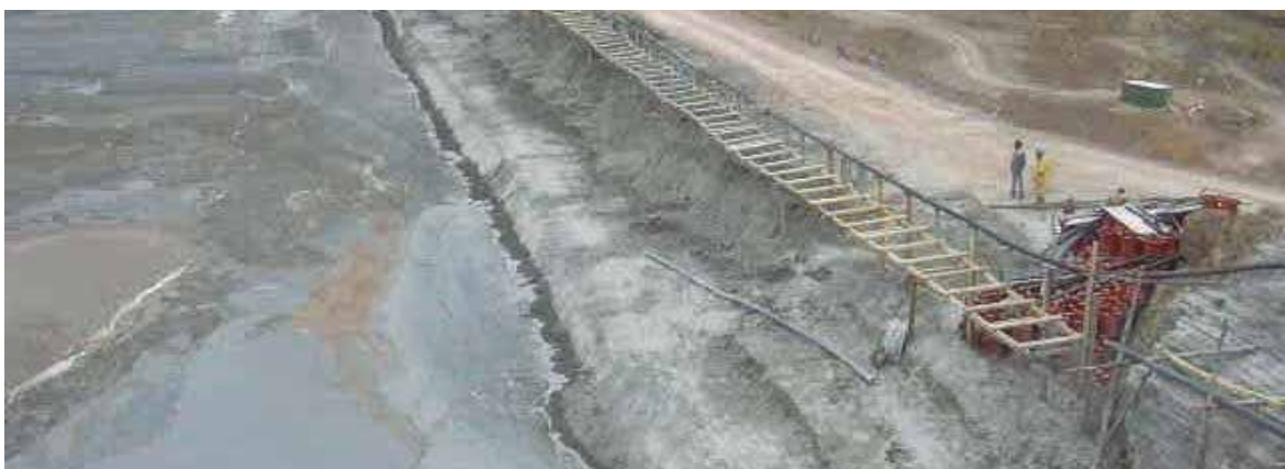
Dique de cola en la cuenca del Pilcomayo, Bolivia.
