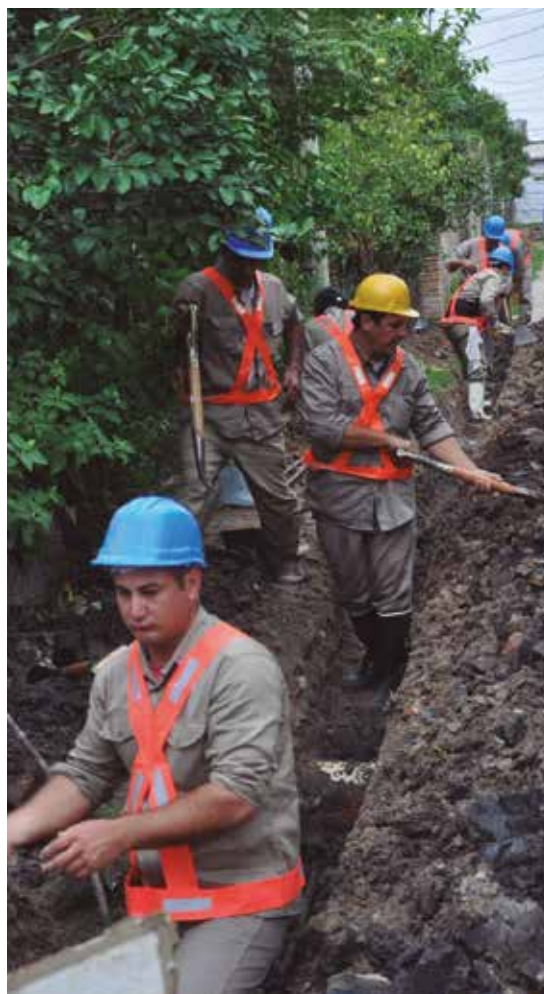
Tendido de redes de agua.
